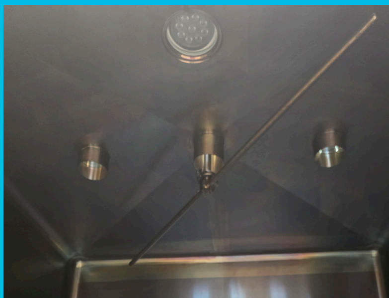
Chambre de lavage – nettoyage du plafond
