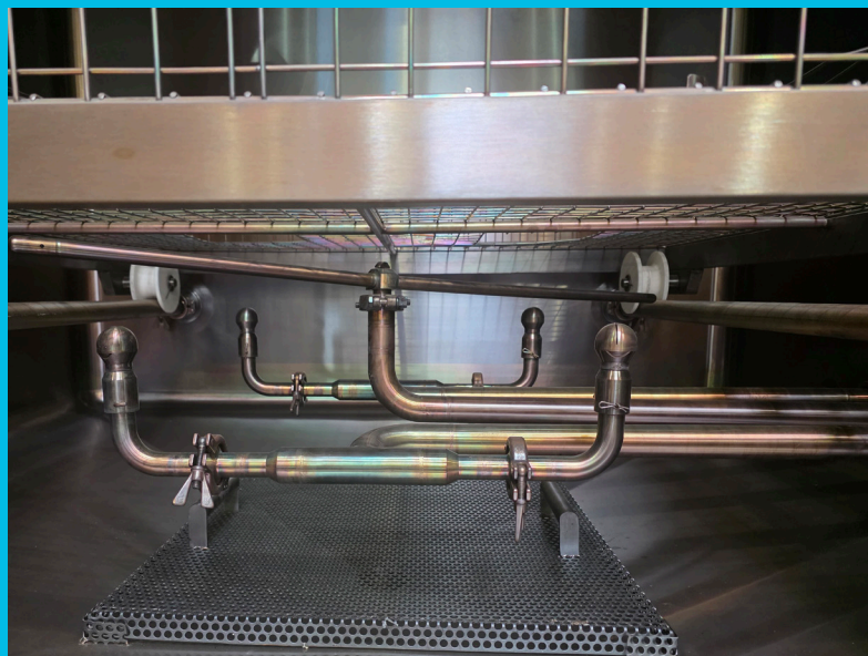
Chambre de lavage – nettoyage du fond
